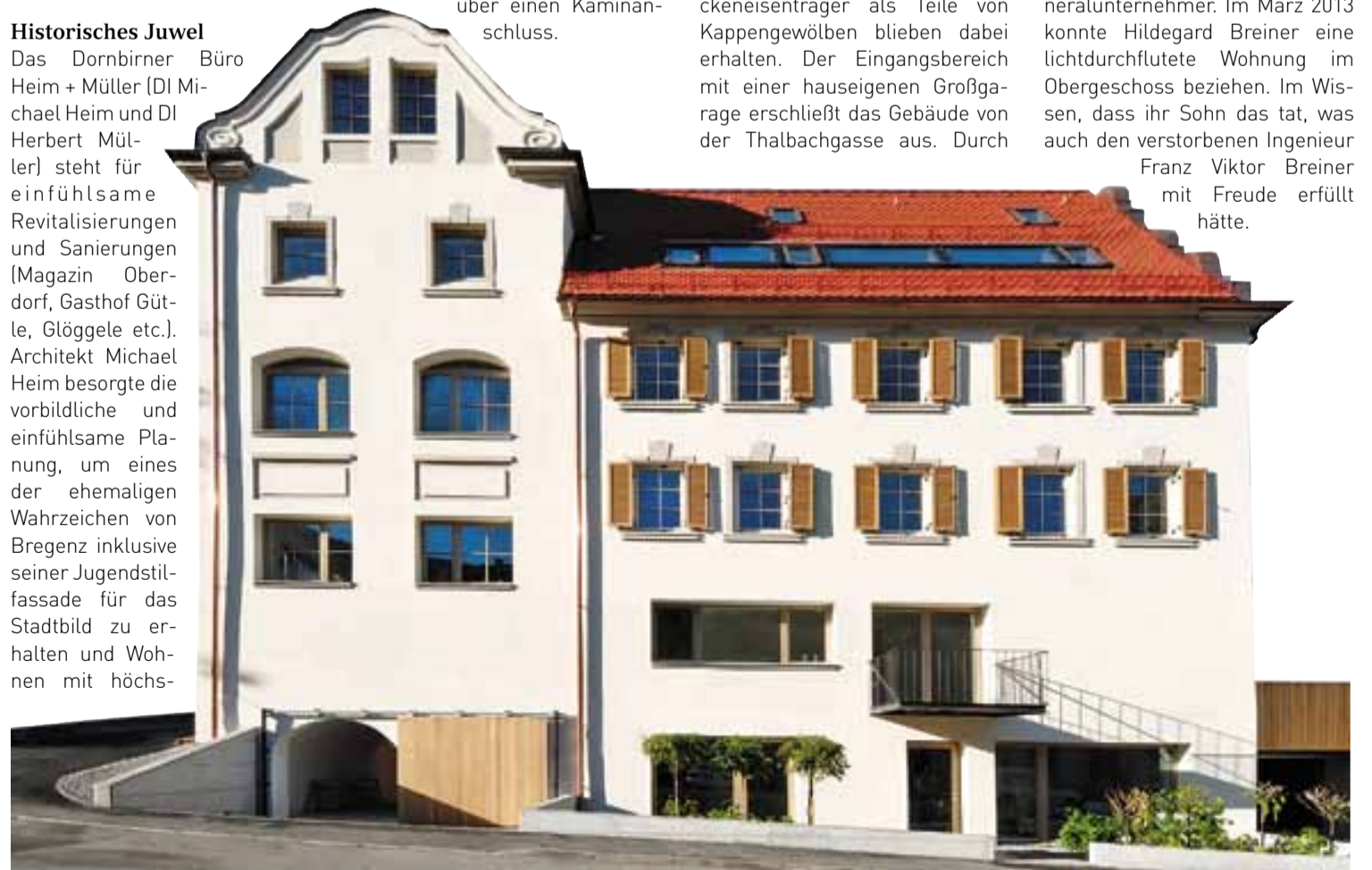
Unter großer Bedachtnahme auf das historische Erscheinungsbild wurde das Gebäude saniert.
