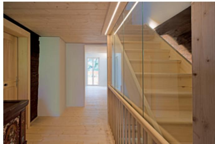
Die bestehende Holzterasse ins Obergeschoss wurde für eine komplette Sanierung demontiert, gebürstet und angeschliffen wieder eingebaut.
